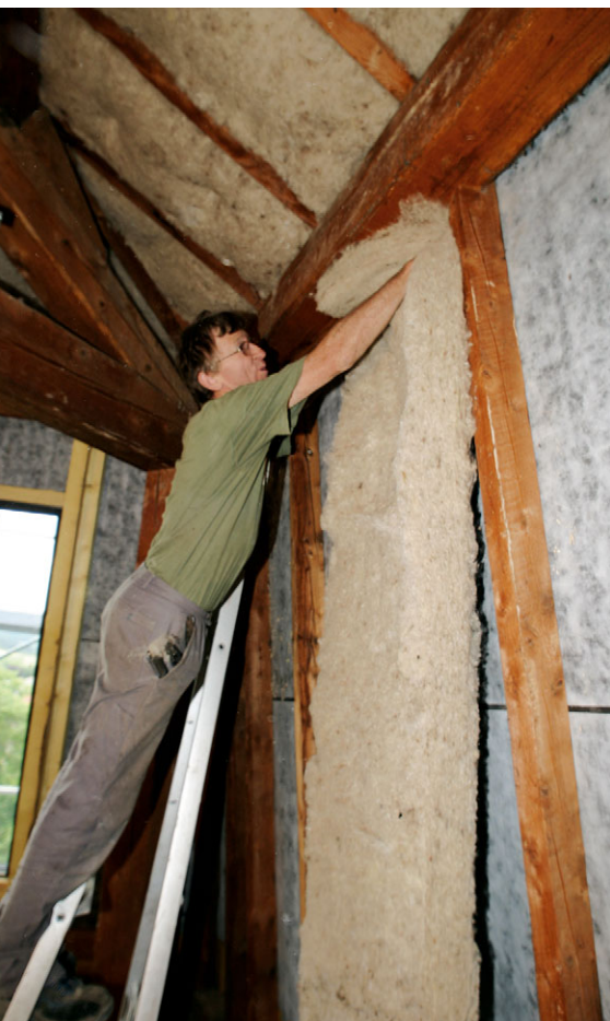
Pose de laine de mouton en rouleau : une mise en œuvre agréable, qui génère peu de poussières.
