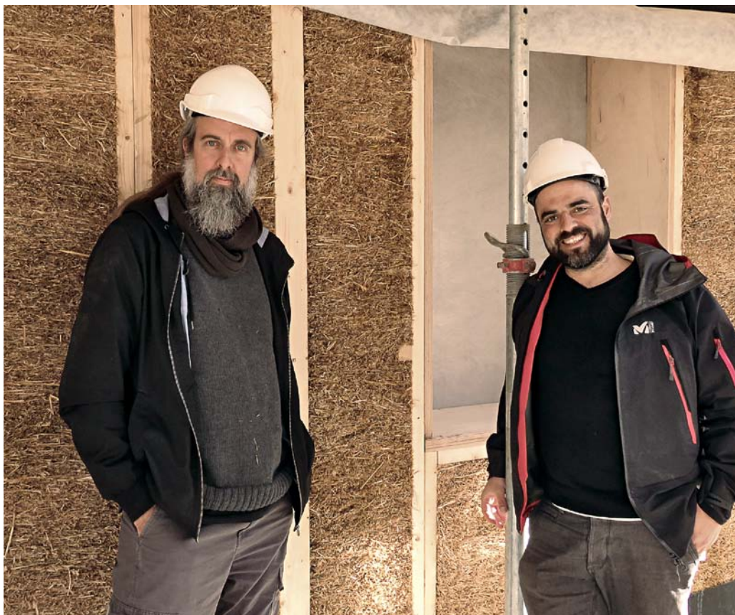
L'architecte Christian Jelk (à g.) est convaincu par la qualité et l'efficacité du système EcoCocon proposé par l'ingénieur Roberto Camarasa. Ces modules préfabriqués bois-paille ont été choisis pour isoler un immeuble en construction à Sainte-Croix (VD).
